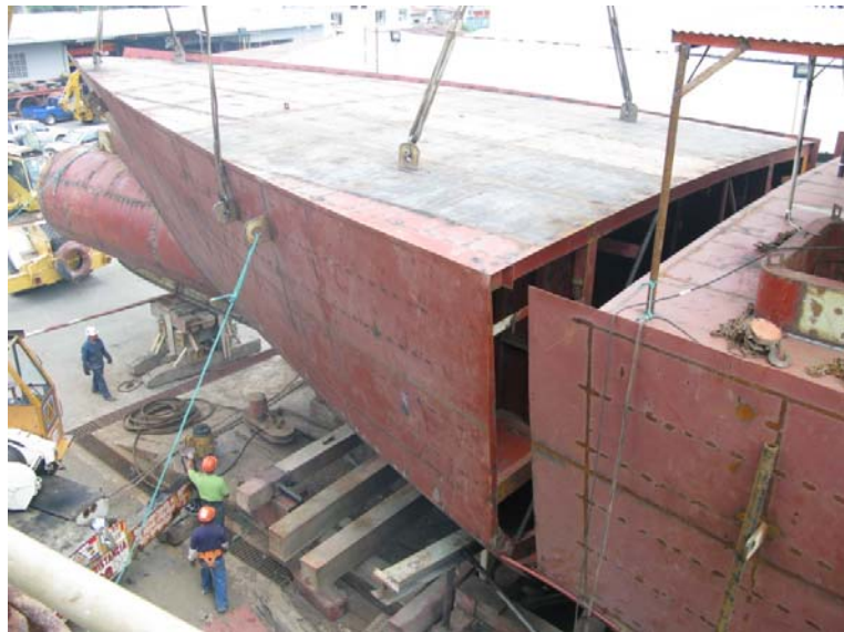
Figura No. 10 Construcción en bloques de barco atunero de 65 metros de eslora
