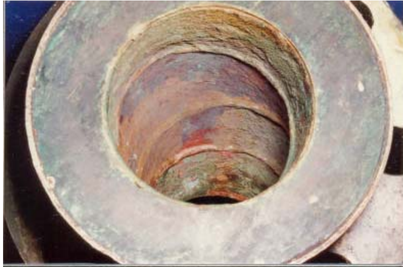
Figura N° 3: Uniones soldadas en tuberías de cuproníquel
