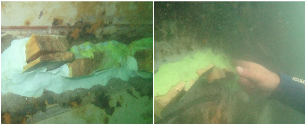
Foto N°4 y N°5 Acciones de obturación mediante cuñas de madera y masilla.
