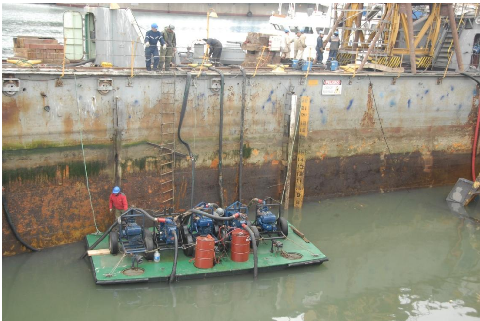
Foto N°20 Uso de balsa con bombas de achique a combustión.
