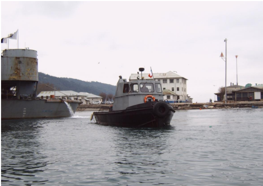
Foto Nº17 Verificación del estado de la proa del dique respecto al fondo.
