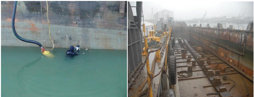
Foto N°15 y N°16 Obturación planchaje interior y picadero del dique seco.
