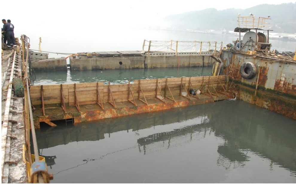
Foto N°19 Mejora en la altura de los tajamares para el dique “Mery”.
