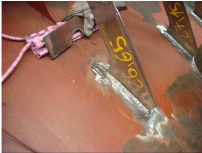
Reemplazo de pie de refuerzo envuelta LC
