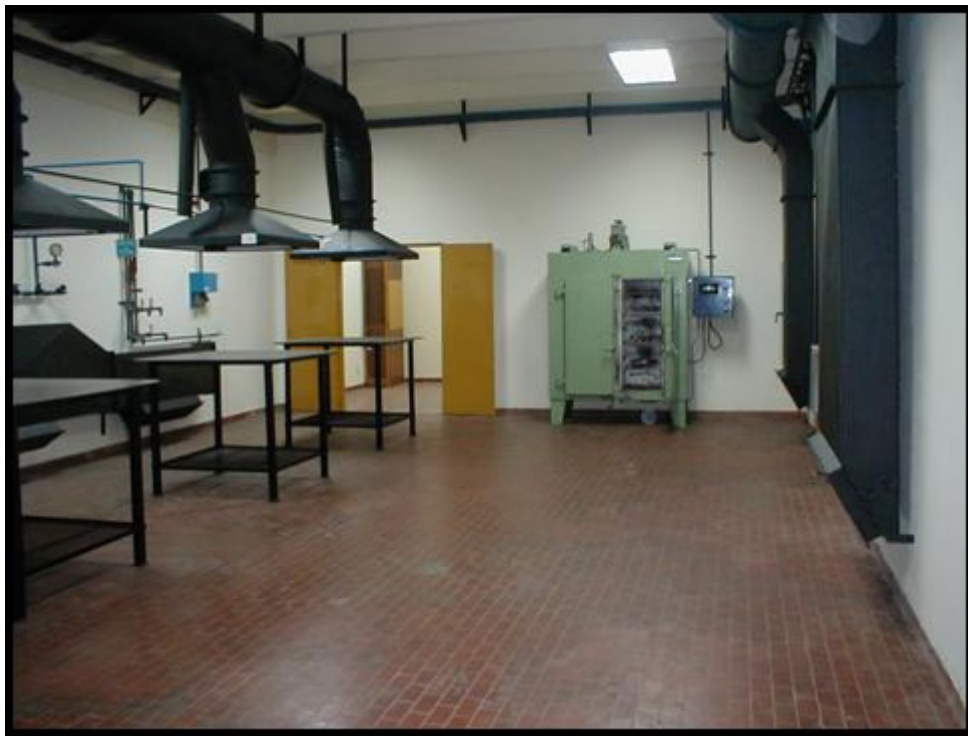
LOCAL DE SOLDADURAS ESPECIALES
