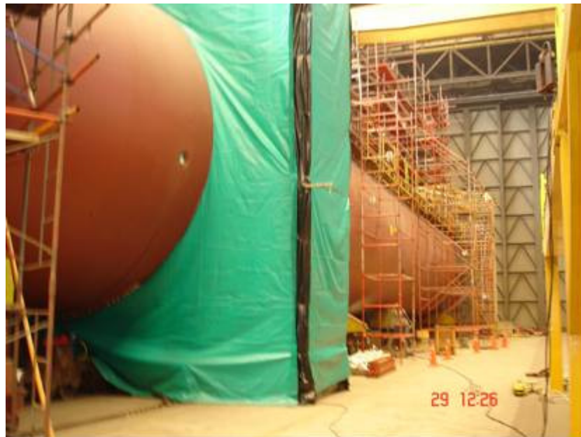
Inicio del armado de la cobertura del área de soldadura
