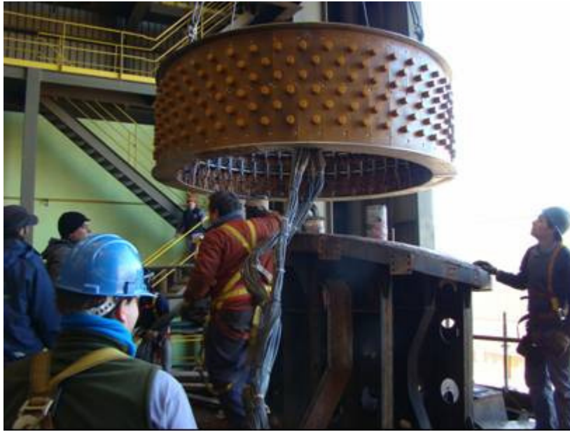
Retiro del arreglo sonar CHA 3-4
