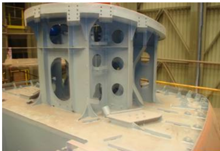
Tratamiento de base de arreglo sonar CHA 3-4
