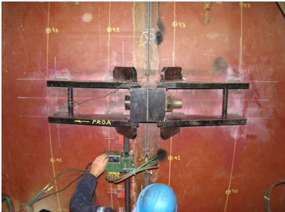
Ejecución del corte circunferencial- Dispositivo de alineación y centrado
