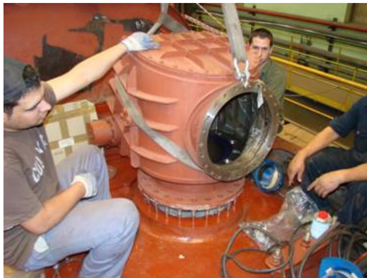
Montaje de válvula externa de snorkel
