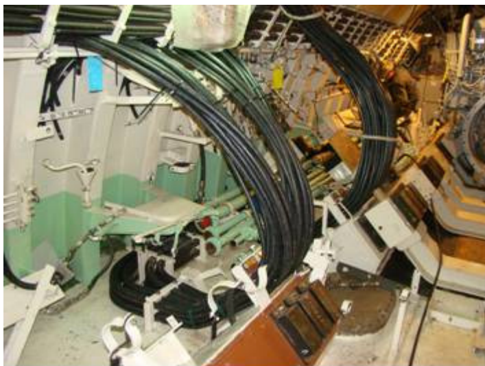
Reemplazo de cables
