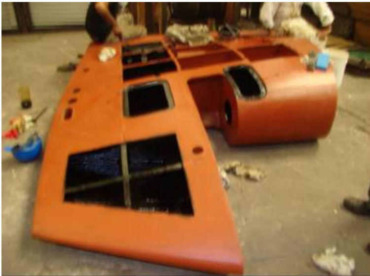
Reparación timón vertical inferior
