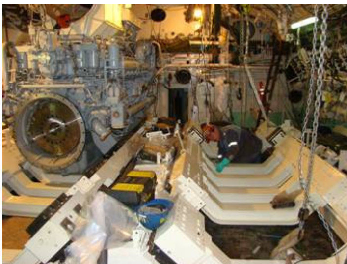
Montaje de bases intermedias de motores
