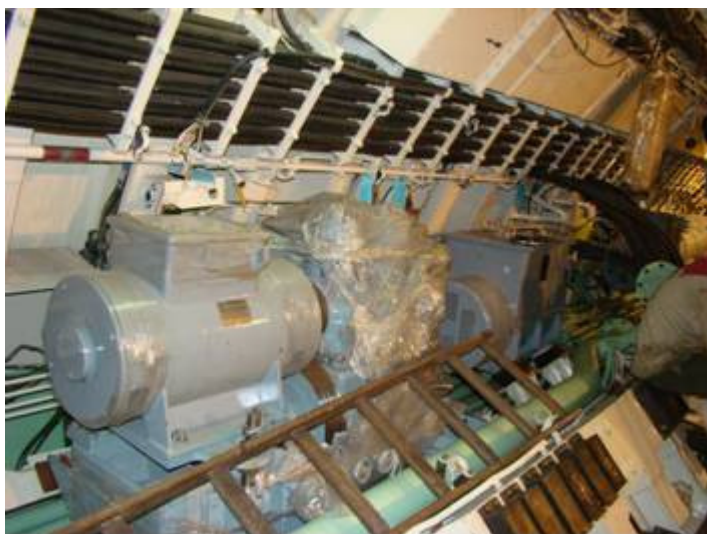
Montaje de convertidores
