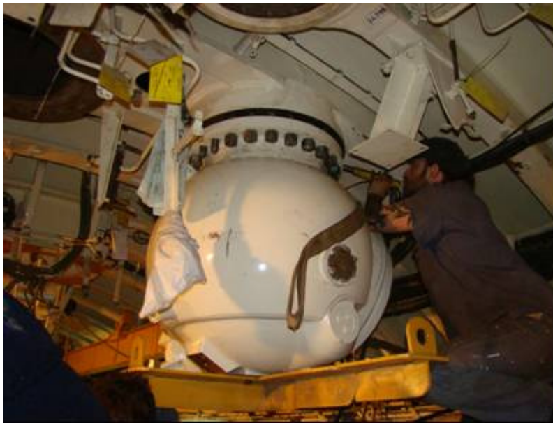
Montaje válvula de snorkel
