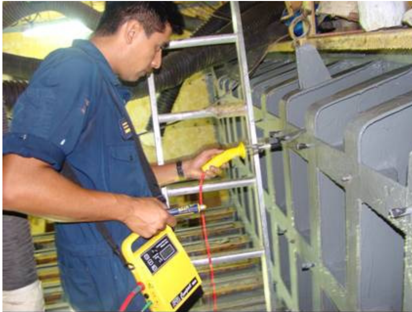
Control de aislación de tanque de baterías
