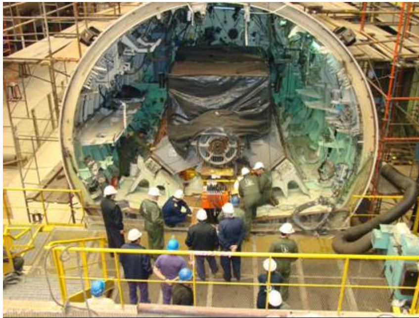
Izado del MEP para reemplazo de tacos resilientes
