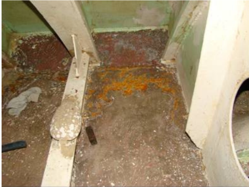
Tratamiento superficial de tanque de combustible
