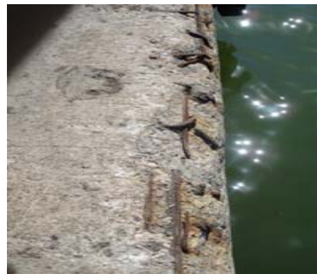
Figura 10. Ausencia de defensas.
