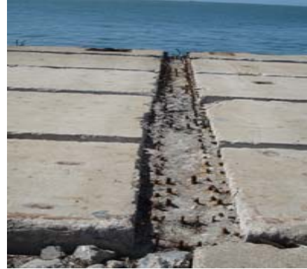
Figura 8. Barras de acero cortadas.
