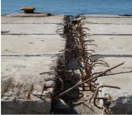
Figura 7. Barras de acero dobladas.
