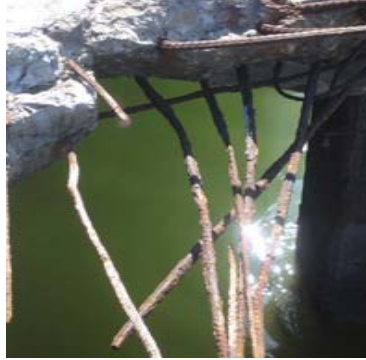
Figura 2. Acero expuesto
