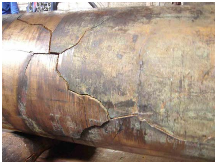
Figura 1: Fotografia da camisa de bronze e numerosas fissuras.
