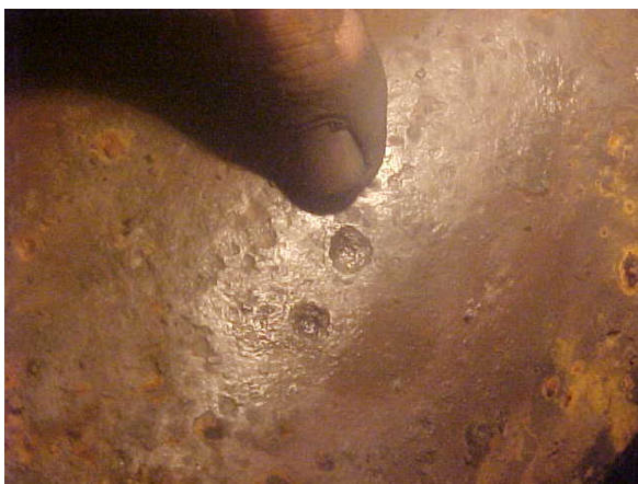
Foto 12 – Ação da corrosão - Pitting
