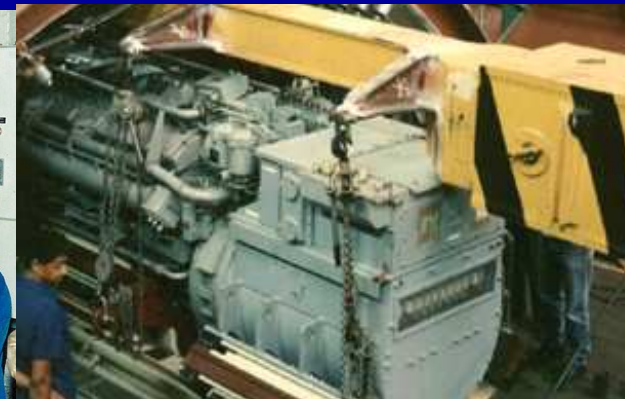
EMBARQUE DO GRUPO MOTOR-GERADOR
