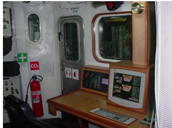
Figura N° 11. Sala de control final
