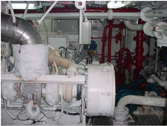
Figura N° 8. Vista de la sala de máquinas Figura N° 9. Vista de la sala de máquinas
