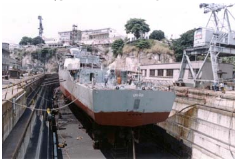
DIQUE ALMIRANTE JARDIM
