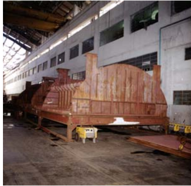
FABRICACIÓN DE ESTRUCTURAS INTERNAS
