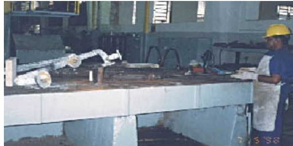
DOBLAMIENTO CALIENTE DE TUBERÍAS
