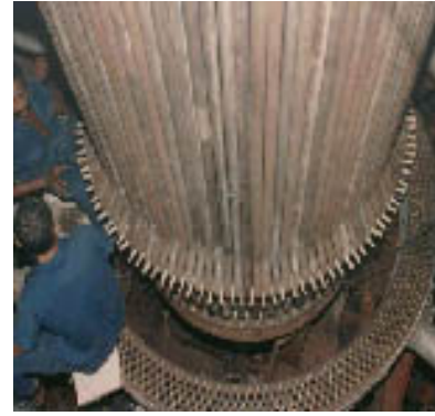
REPARACIÓN DE CALDEIRAS
