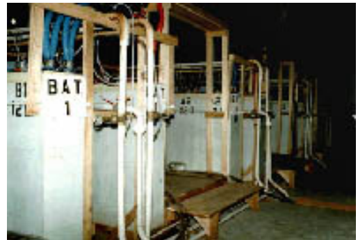
GALPÓN PARA ACTIVACIÓN DE BATERÍAS
