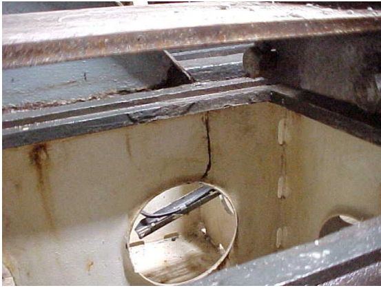
Figura N° 5 Falla en cuaderna en zona timón
