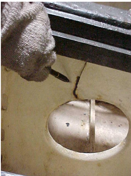
Figura N° 4. Falla en cuaderna de la unidades
