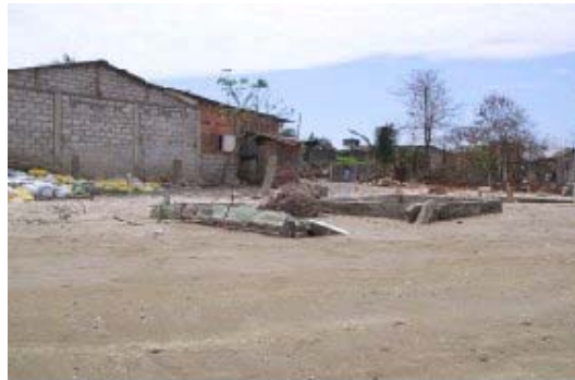
Foto 4. Vivienda destruida en su totalidad por la furia del mar. Se aprecian los sacos de arena cerca de otra vivienda expuesta a la investida del mar, como medios de protección.
